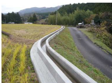
農業用排水路
