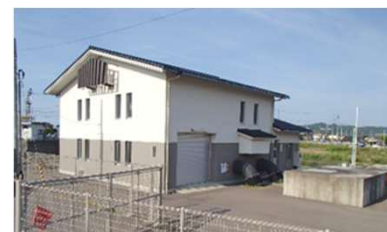
排水機場の整備
