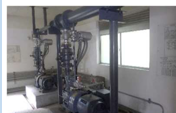
かんがい施設更新状況
