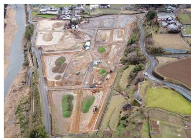
ほ場整備施工状況（野村）
