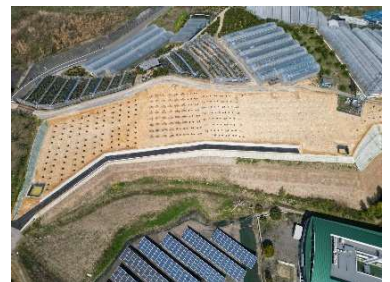
[図24] 樹園地再編整備の施工状況(砥部地区)
