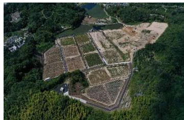
【図26】樹園地再編整備の施工状況（下難波地区）
