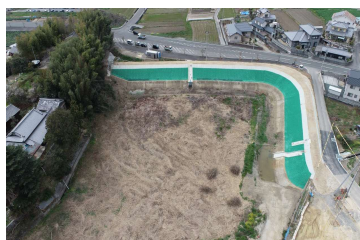
【図28】農業用ため池の老朽化対策施工状況（夏目古池）
