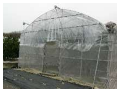
ハウスの整備
