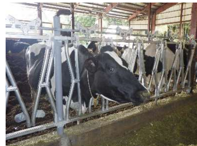
牛舎の補改修
