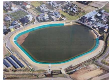
[図23] 農業用ため池の老朽化対策施工状況 (吾川地区市ノ坪池)
