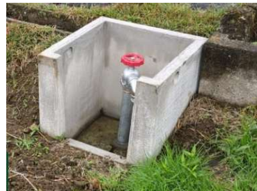
〔図11〕用水路のパイプライン化 給水栓施工状況（ナベラ地区）
