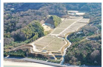
樹園地の再編復旧 （上浦地区盛工区）
