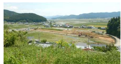
ため池改修状況
