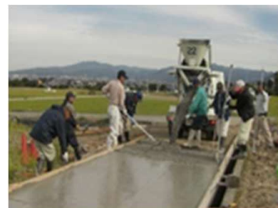
農道の簡易舗装
