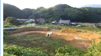
ため池改修工事中
