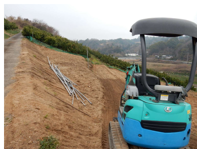
農家自主施工による緩傾斜化
