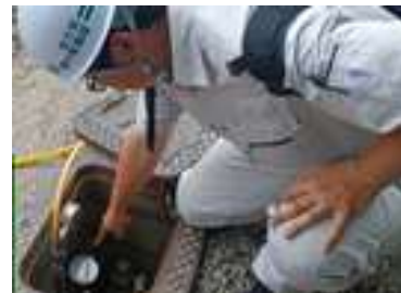
〔図12〕用水路のパイプライン 加圧試験状況（永子地区）
