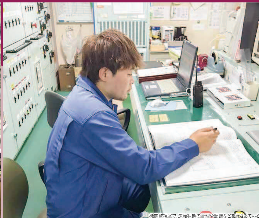
機関監視室で、運転状態の管理や記録などを行っている
