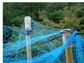
ペットボトルによる先端部処理
