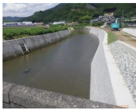
河道拡幅及び護岸改修
