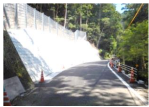
迂回路がない道路の改良
