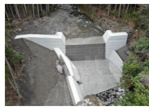
砂防堰堤修繕
