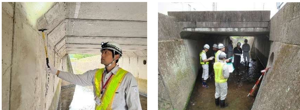
図 10 直営点検状況
