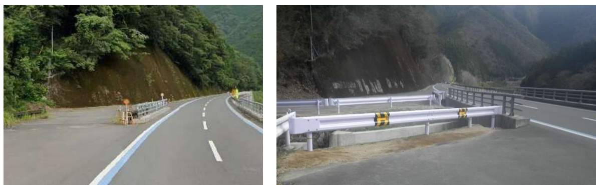
図8 撤去事例（小唐井橋（旧））（左：撤去前、右：撤去後）
