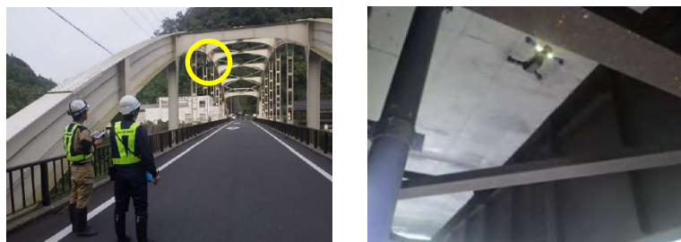
図7 新技術を活用した点検（船戸橋）
