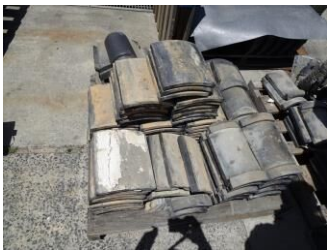
現場で瓦の取出し
