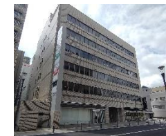
⑧明治安田生命松山二番町ビル
