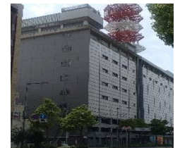
⑥NTTドコモビジネス松山ビル
