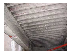
石綿含有吹付け ロックウール （鉄骨材の耐火被覆）
