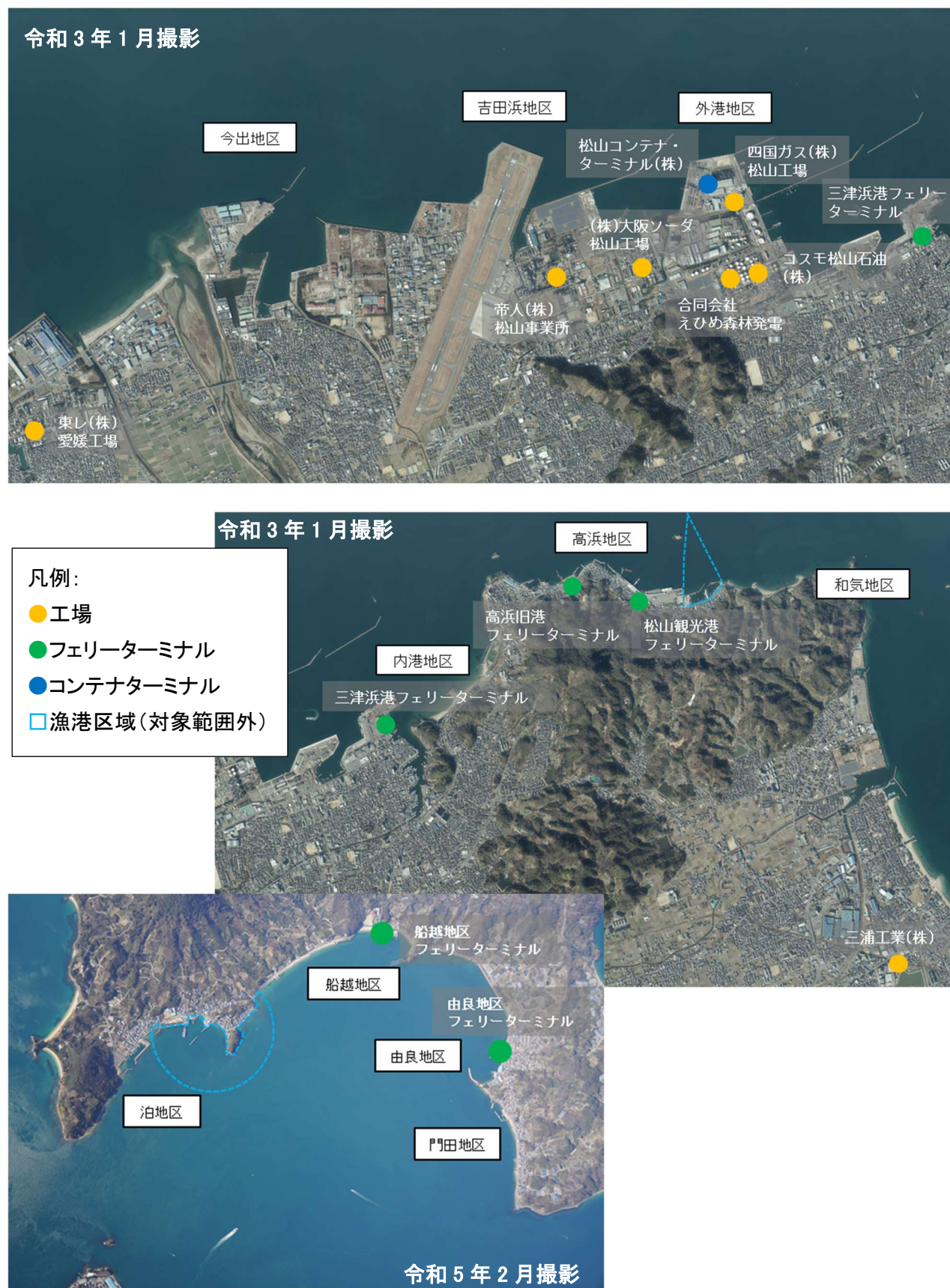
図 1-3 松山港の特徴（今出・吉田浜・外港・内港・高浜・和気・泊・船越・由良・門田地区） （写真提供：国土交通省 四国地方整備局 松山港湾・空港整備事務所）
