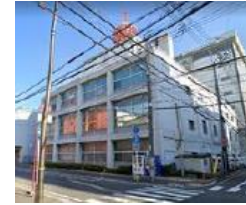
①NTT愛媛ビル2棟
