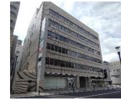
⑧明治安田生命 松山二番町ビル
