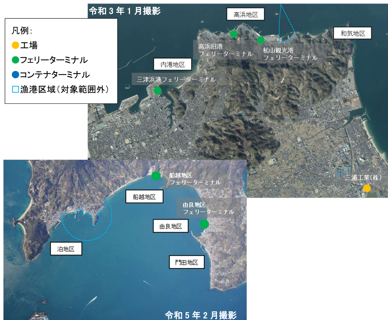
図 1-3 松山港の特徴（今出・吉田浜・外港・内港・高浜・和気・泊・船越・由良・門田地区） （写真提供：国土交通省 四国地方整備局 松山港湾・空港整備事務所）
