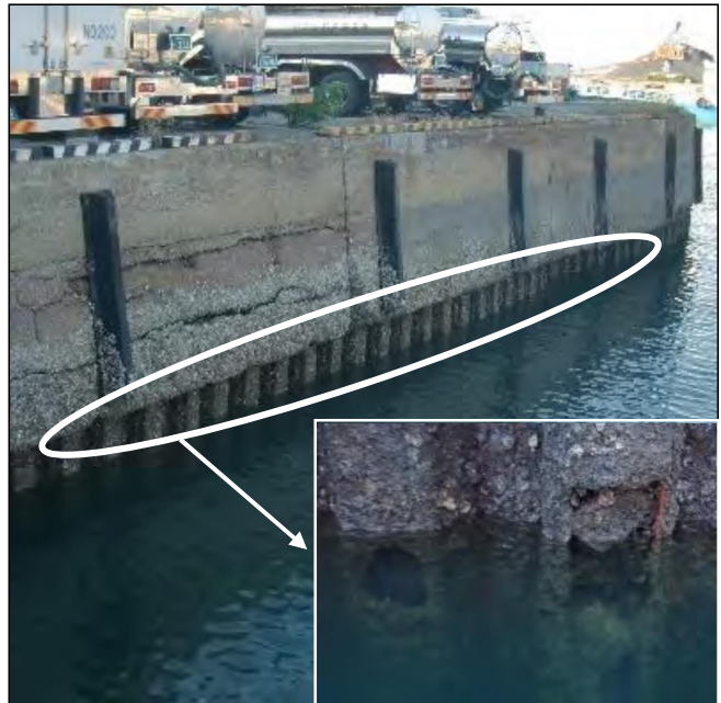
長寿命化計画 点検実施状況
