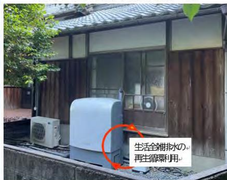
既存住宅の外に設置（配管接続工事）
