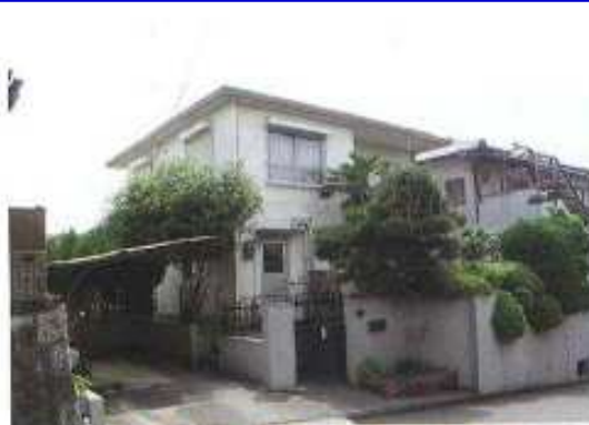
まだ使用できる空き家
