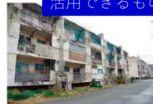
共同住宅の空き家
