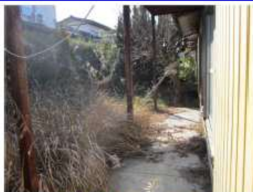
雑草が繁茂した空き家
