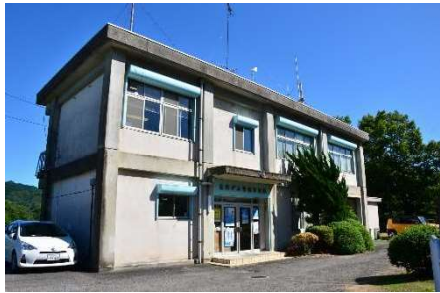
ダム管理事務所
