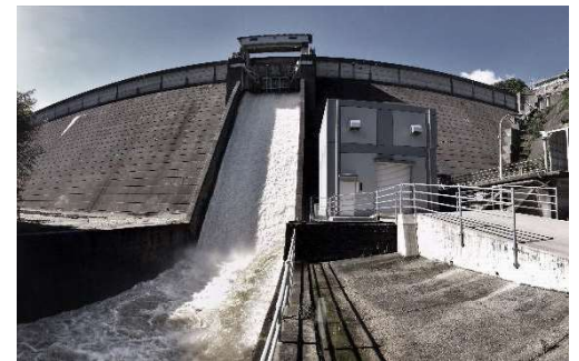
ゲート操作によるダムからの放流状況
