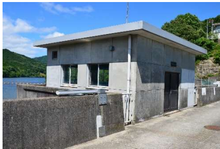
取水ゲート操作室
