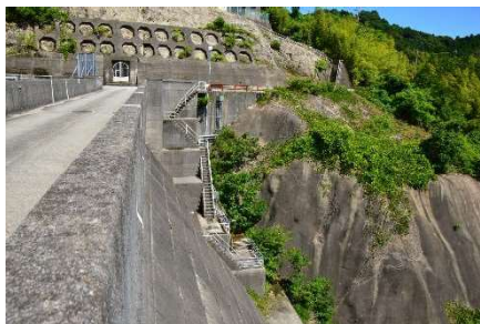
管理用階段通路
