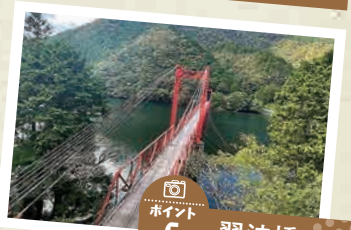
ポイント 5 白滝鉱山架空索道 金砂湖支柱遺構
