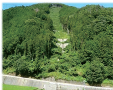
【山地災害跡地への 治山施設整備】
