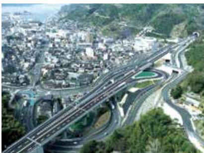
大洲・八幡浜自動車道
