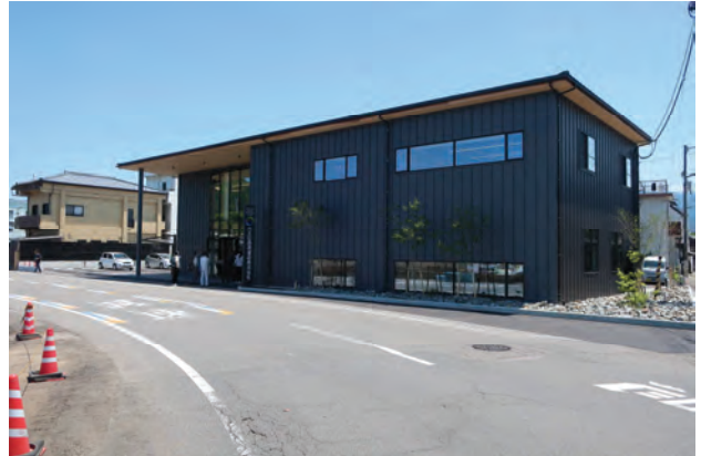
CLT建築物支援事業 (川之江港湾運送(株)事務所)
