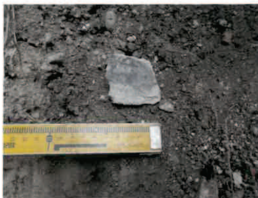
かご枠前面地盤に含まれる瓦の破片
