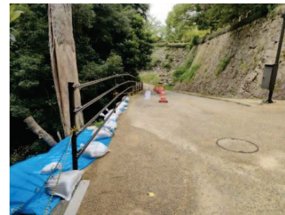
応急対策完了（A箇所）
