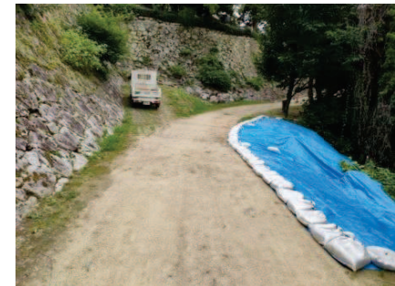
応急対策完了（B箇所）
