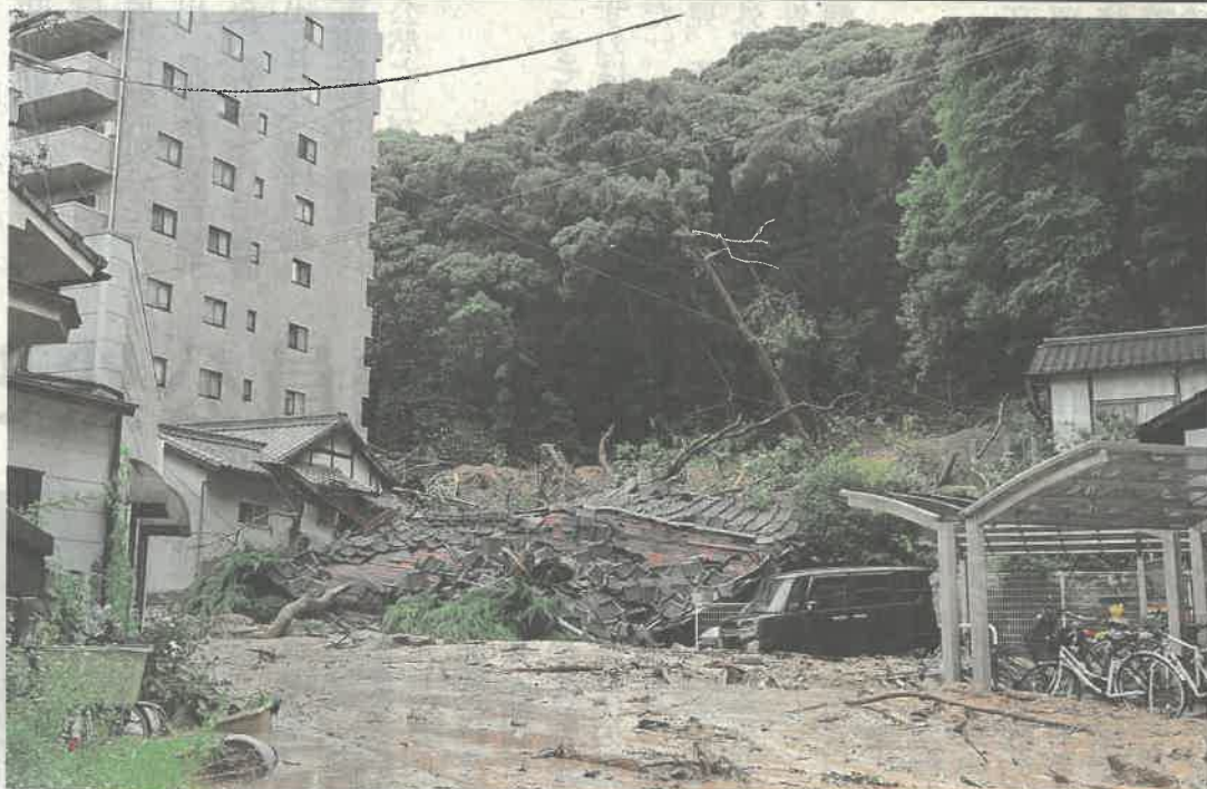
松山城の城山斜面が崩れ、倒壊した民家―12日 午前5時40分ごろ、松山市緑町1丁目
