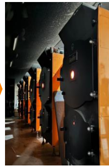
③ 薪ボイラーで源泉を適温に調整
