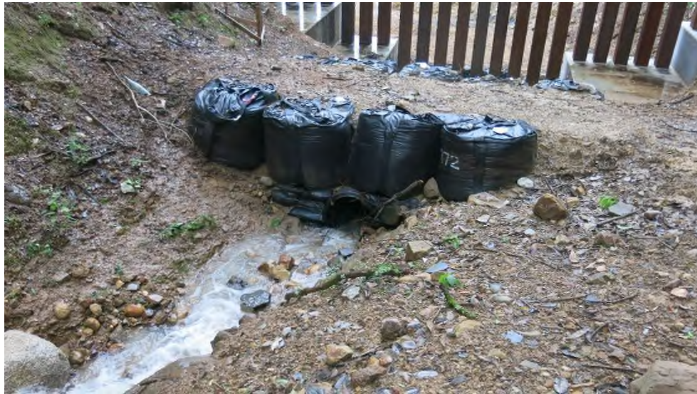
写真⑩ 排水管呑み口につまりはない。
