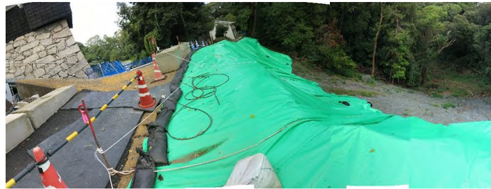
写真④ 緊急車両用道路の状況（変状なし）
