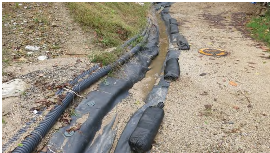
写真③ 緊急車両用道路の水路越水管所
