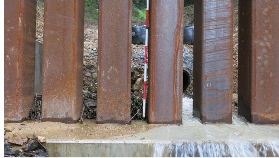
写真⑫ 仮設対策工 VCCO の土砂堆積状況（流水部分は土砂撤去し流水確保）
