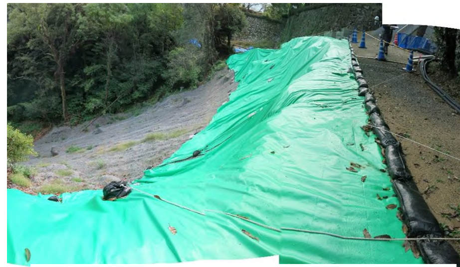
写真⑤ 緊急車両用道路の状況（変状なし）
