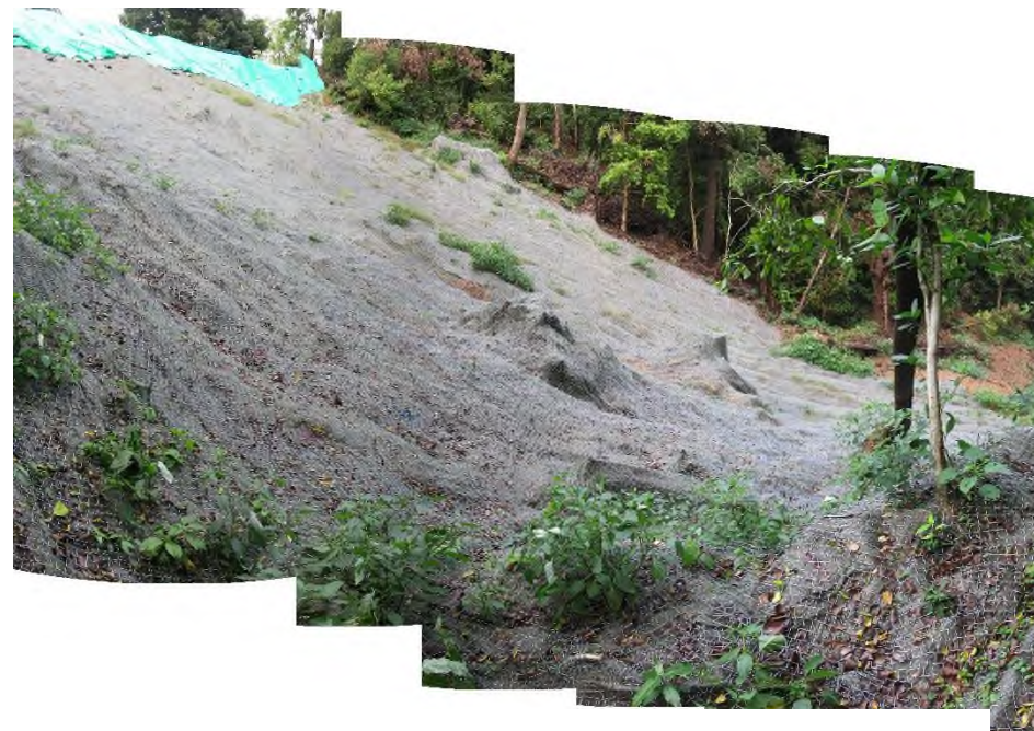
写真⑥ 上流部上部斜面状況（変状なし）
