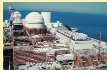
② 3号機建設工事
