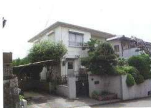
まだ使用できる空き家
