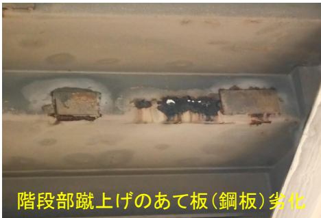
階段部蹴上げのあて板(鋼板)劣化
