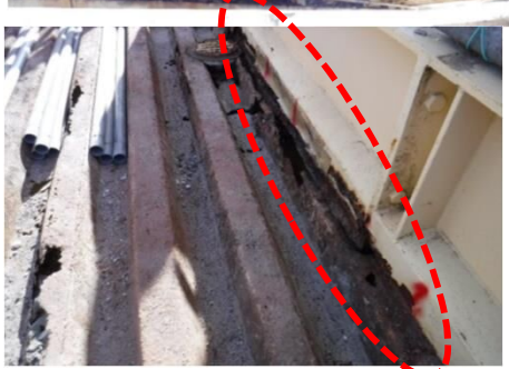
※ 舗装を除去した後の地覆の状態
