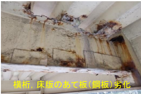
主桁のあて板(鋼板)劣化
