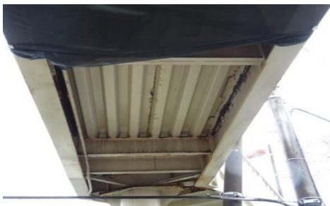
※デッキプレート 横方向の接合部
