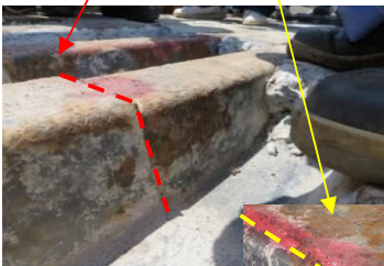
※デッキプレート 方向の接合部
