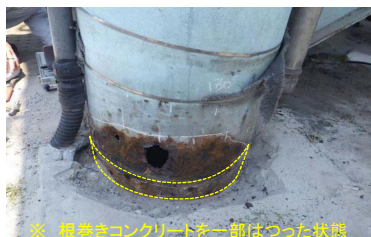
※ 根巻きコンクリートが一部はつった状態
