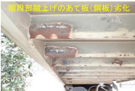
階段部蹴上げのあて板(鋼板)劣化
