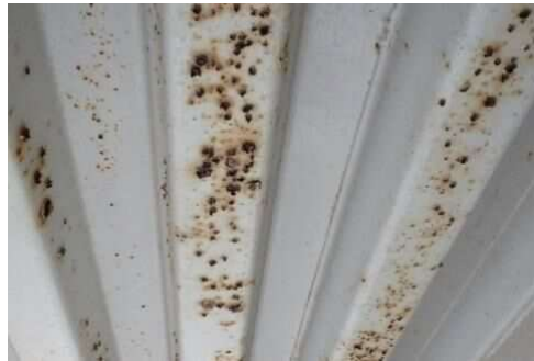
損傷の面積が大の例（着目部分の50%以上に錆が生じている又は局所的な錆が着目部分内に多数発生して結果として着目部分の範囲内で拡がっている例）
