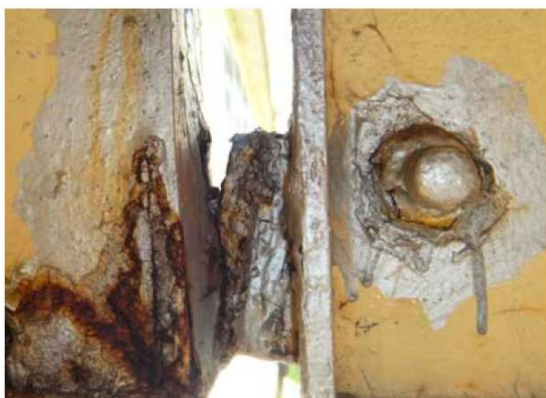
フックの溶接の状態 (接合部)
