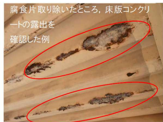
腐食片を取り除いた状態の例（床版）
