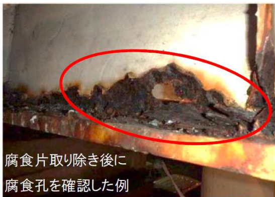
腐食片を取り除いた状態の例（主桁）
