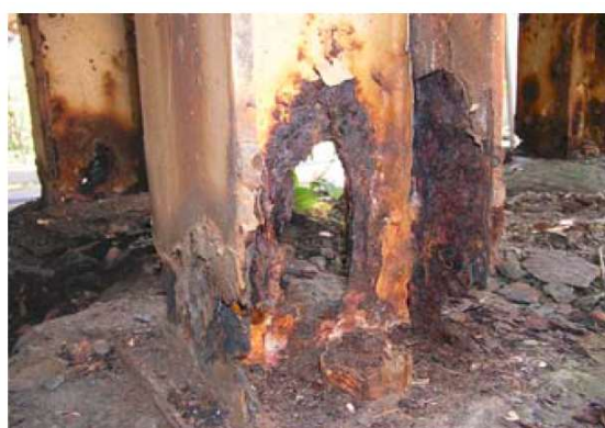
腐食片を取り除いた状態の例（下部）
