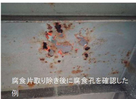
腐食片を取り除いた状態の例（床版）
