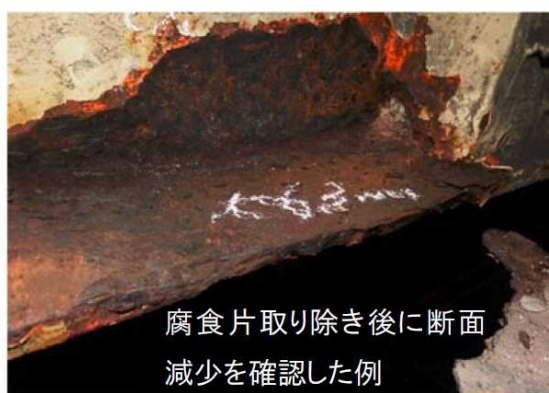
腐食片を取り除いた状態の例（主桁）
