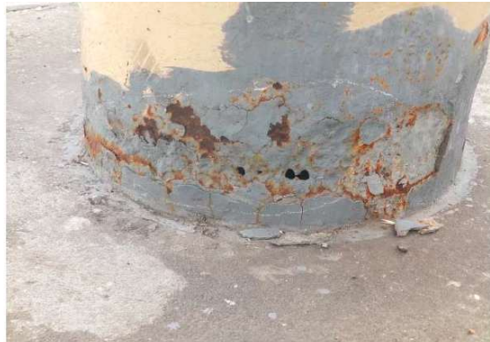
腐食片を取り除いた状態の例（下部）
