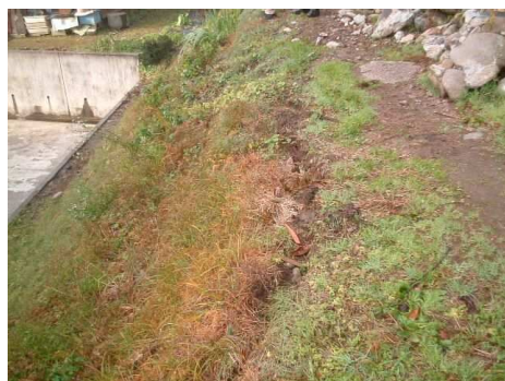
写3-8 のり面のクラックの例
