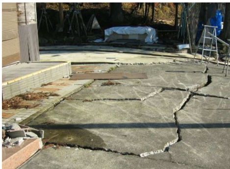
写３－２ 宅地地盤のクラックの例
