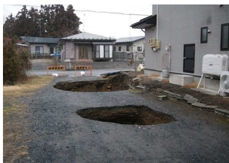
写 3-3 宅地地盤の陥没の例
