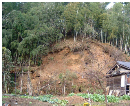
写 3-10 のり面のガリー浸食の例
