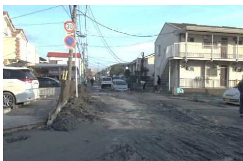
(a) 液状化の被害
