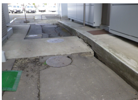
写 3-4 宅地地盤の沈下の例
