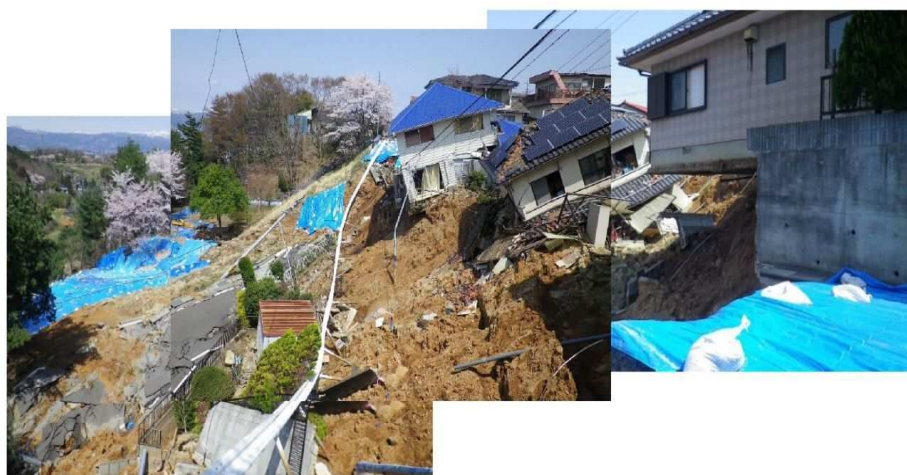
写 3－11 のり面の崩壊の例
