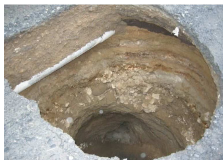
写 3-3 宅地地盤の陥没の例
