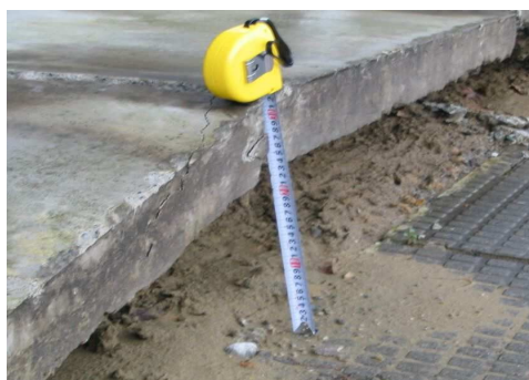
写 3-5 宅地地盤の段差の例
