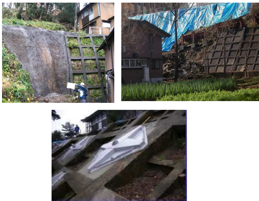
写 3-12 のり面保護工の変状の例
