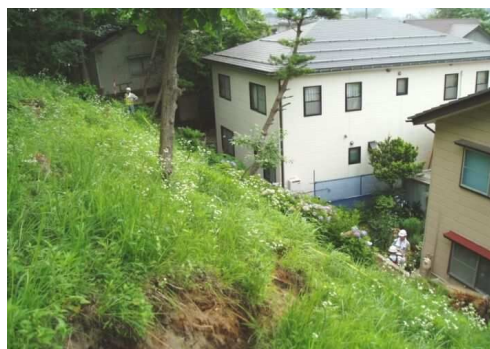
写3-8 のり面のクラックの例
