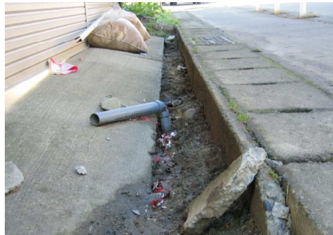
写 3-5 宅地地盤の段差の例
