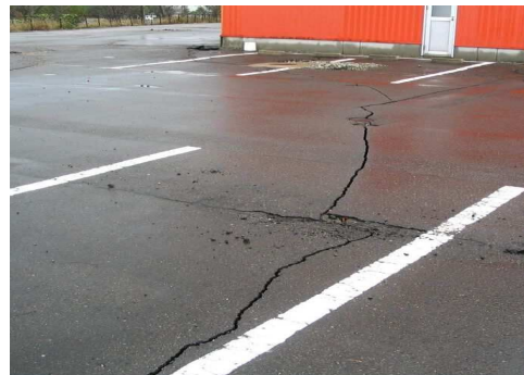
写３－２ 宅地地盤のクラックの例
