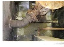
③ ばっ気沈砂槽 散気装置
