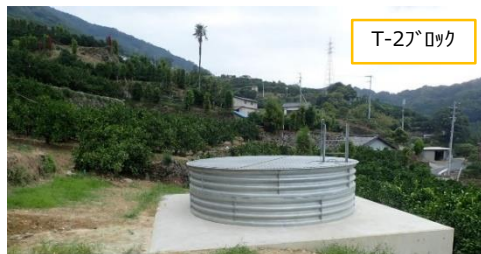
集水井工 (T-27°07、完成)
