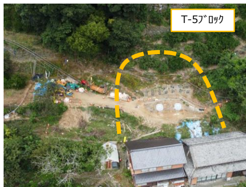
アンカー工 (T-57°07、施工中)
