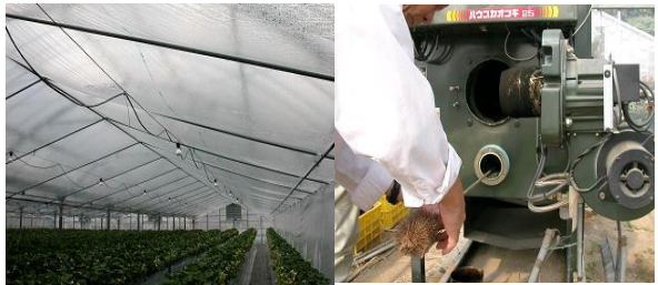
写真1 ハウスの多層被覆と暖房機
