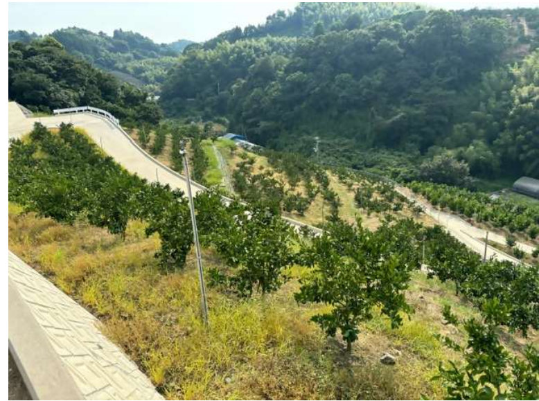
改良復旧 R5.3植栽 河内
