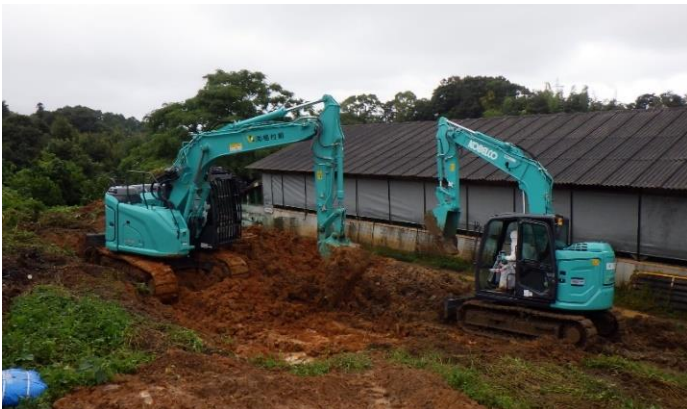
③ 埋却溝の掘削 (11/2 撮影)
