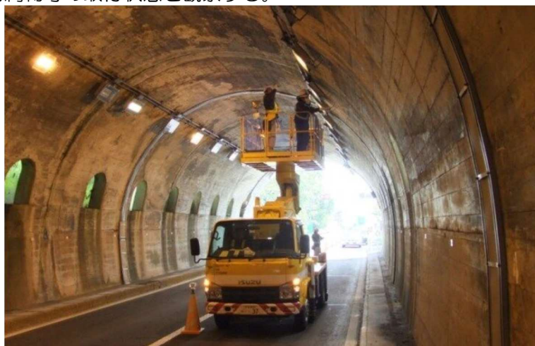
写真一解5. 1 近接目視作業状況
