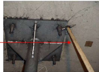
打音検査の例
