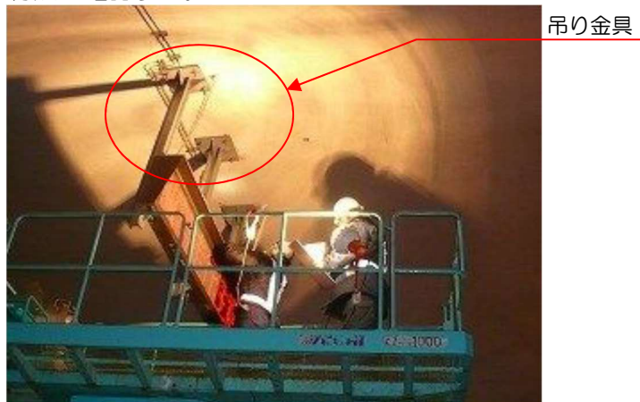
写真一解5. 3 触診作業状況
