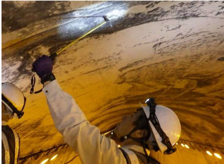
(a) トンネル本体工
