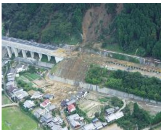
H16 台風第21号 がけ崩れ（新居浜市）
