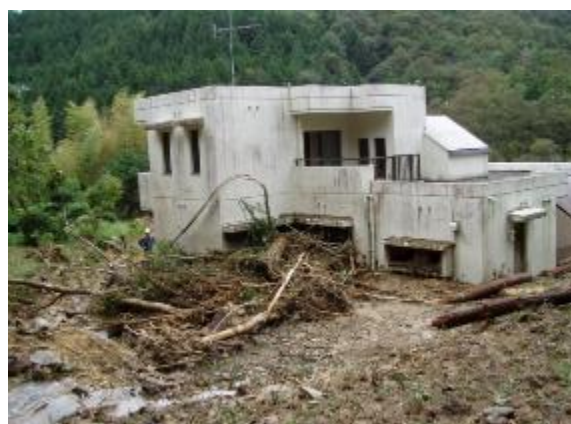
H16 台風第12号 土石流（四国中央市）
