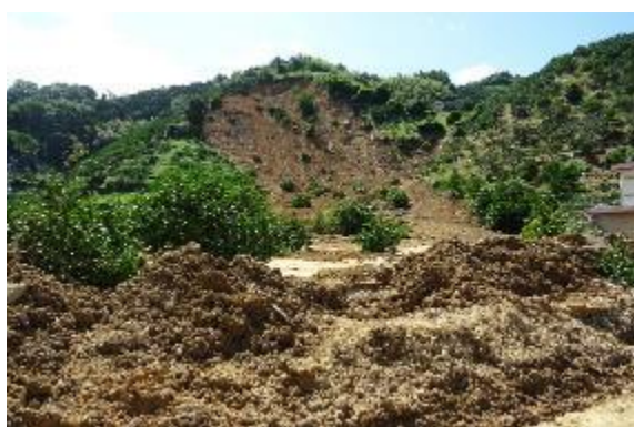
H30 西日本豪雨 土砂崩れ（宇和島市）
