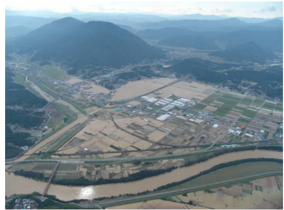
H16 台風第16号 肱川氾濫（大洲市）
