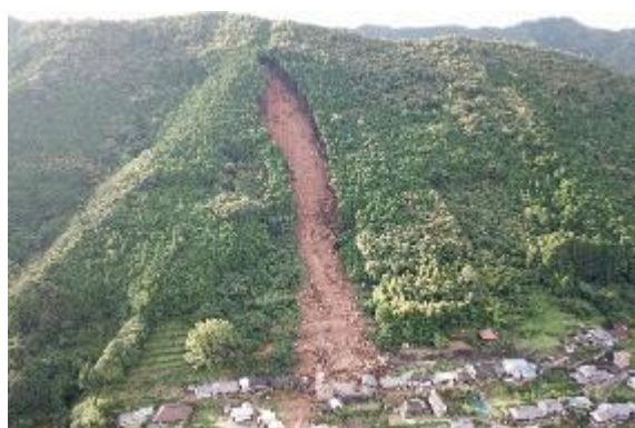
H30 西日本豪雨 土砂崩れ（西予市）
