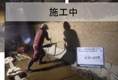
せん断補強鉄筋施工
