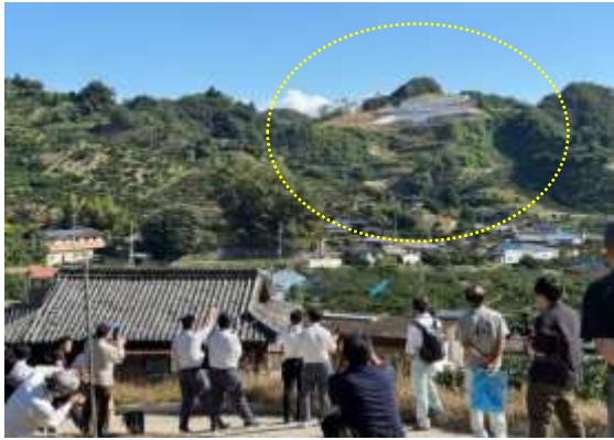
【再編復旧「玉津地区」(白浦工区)】
