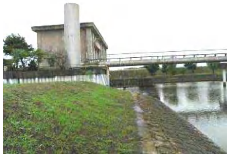
排水機場の法面での生育状況
