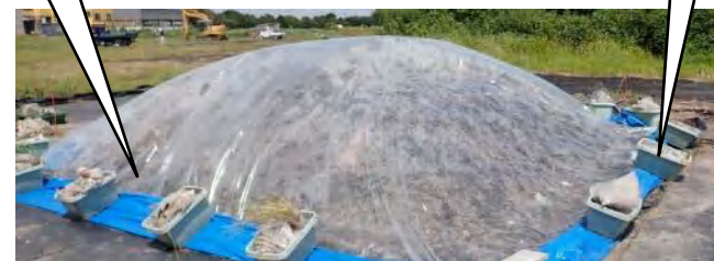
透明なビニールシートを被覆した泥土
