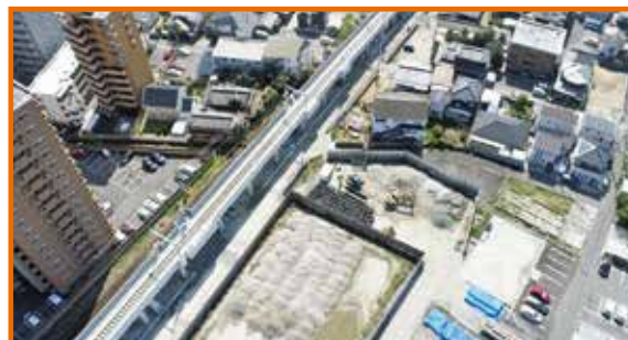
駅南側(令和6年3月撮影)
