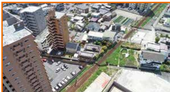
駅南側(平成31年4月撮影)
