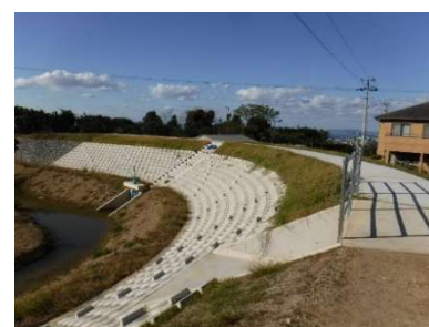
ため池の改修
