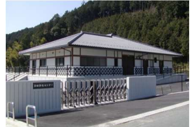
農業集落排水施設
