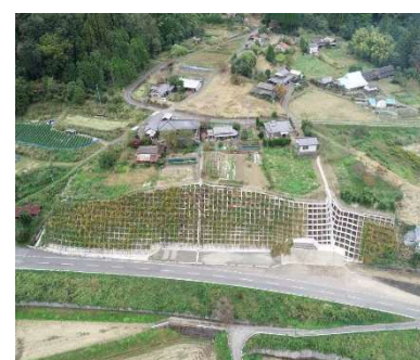
地すべり対策（法枠）
