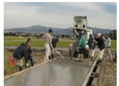
農道の簡易舗装
