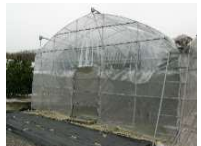
ハウスの整備
