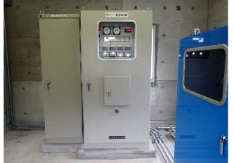
大久保山ダム取水施設更新整備完了
