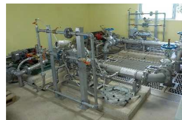
かんがい施設更新状況
