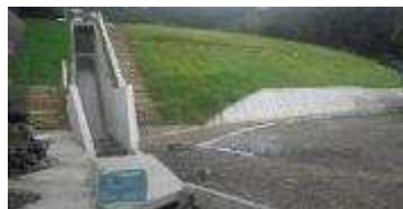
ため池の改修整備
