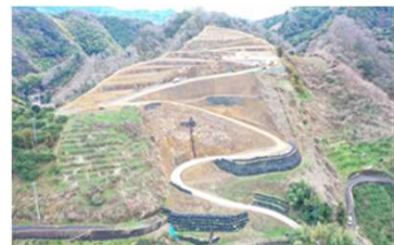
再編復旧工事中
