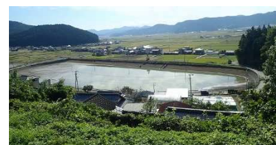
改修予定のため池
