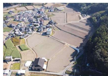
ほ場整備施工状況
