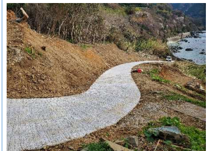
海岸補修仮設道路
