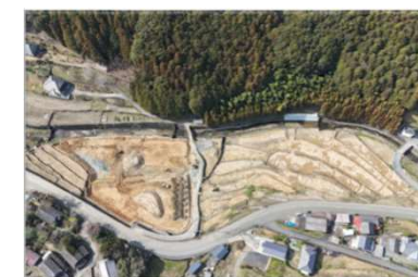
区画整理施工状況
