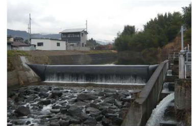
図10 更新工事が完了した和田ノ窪地区の頭首工
