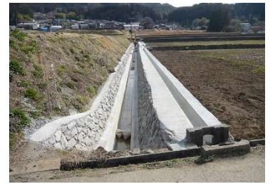
図9 更新工事が完了した明神地区の用排水路
