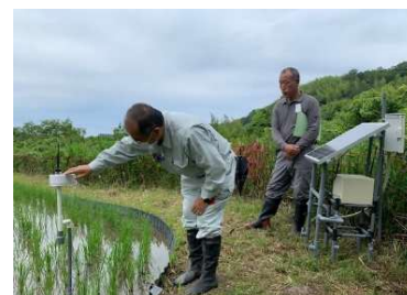
図9 水位センサー設置
