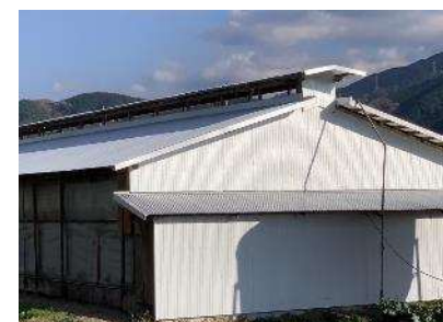
断熱効率の高い資材による 畜舎屋根の補改修（養豚）
